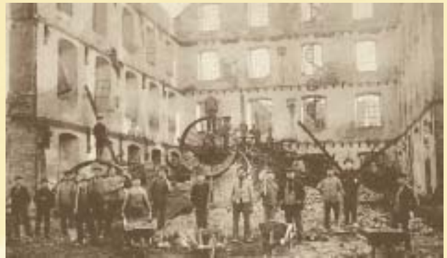
Die vom Feuer zerstörte Fabrik Drecker & Kuhlmann
