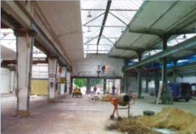
Das Logistik-Zentrum in der Aufbauphase
