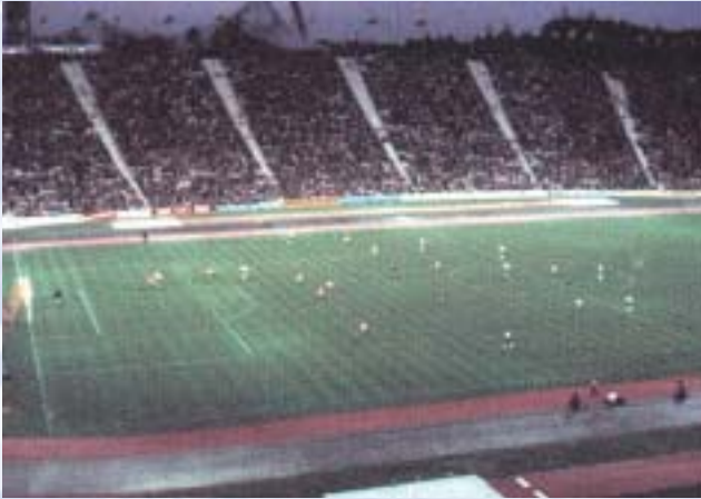
Das Olympia Stadion in München beleuchtet mit Halogen-Metall dampflampen 3500 W für sofortige Wiederzündung
