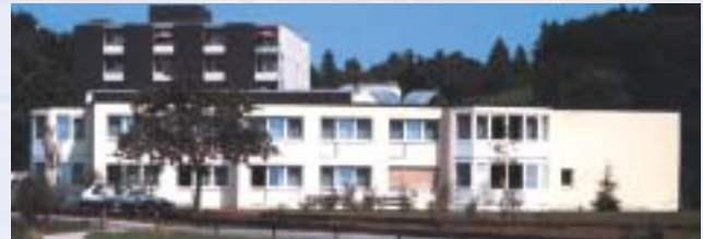
Das Altenzentrum am Sonnenweg, Ansicht von der Stadtseite
