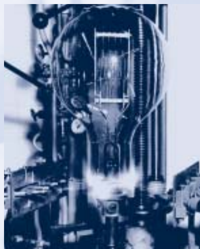
Einschmelzen der größten Lichtwurf Lampe mit einer Leistung von 20.000 Watt
