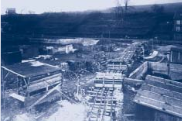
Baustelle der Gaserei 1925
