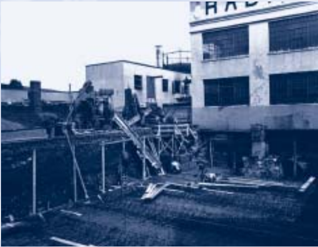
Neubau Lagergebäude mit Festsaal und Luftschutzbunker 1937 bis 1939
